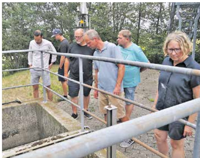
Endstation der Abwasserreinigung - hier wird das gereinigte und geprüfte Abwasser in die Mittelebrach geleitet. Fotos: E. Pieger
