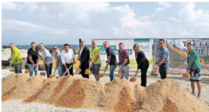
Mit dem offiziellen Spatenstich wurde nun der Startschuss für den Bürgerwindpark Burgebrach-Walsdorf gegeben. Foto: E. Pieger
