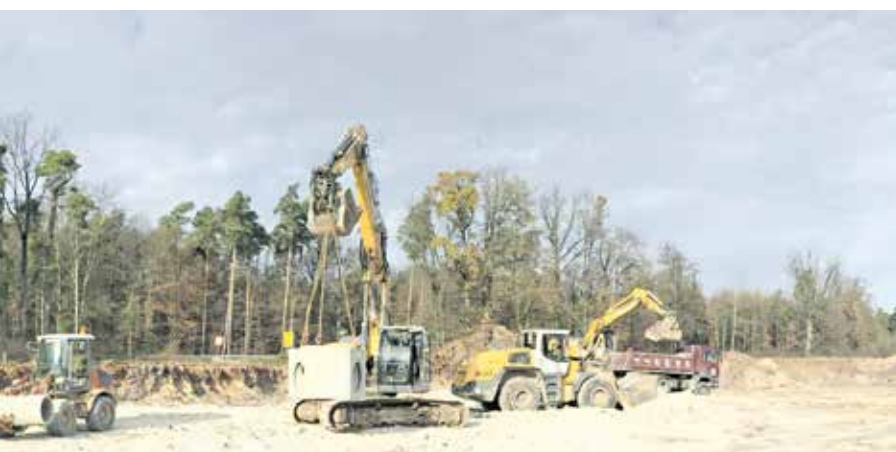
Erweiterungsbau Hochregallagerhalle Musikhaus Thomann in Treppendorf.
