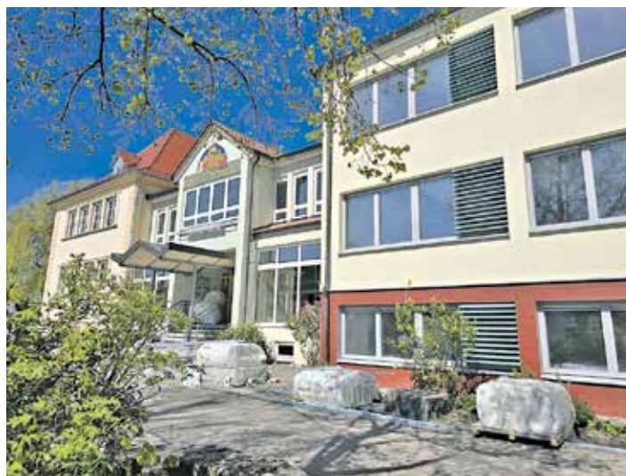
Die Grundschule Burgebrach wird derzeit saniert.
