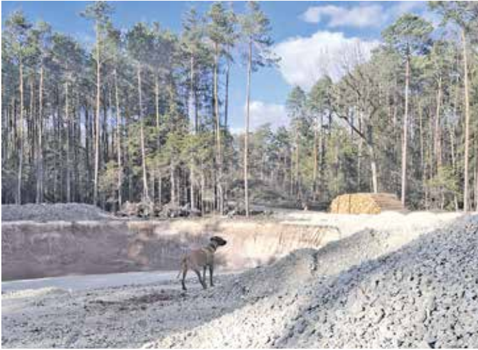
Großbaustelle Windräder im Süden von Walsdorf. Foto: B. Wolfrum-Reichel
