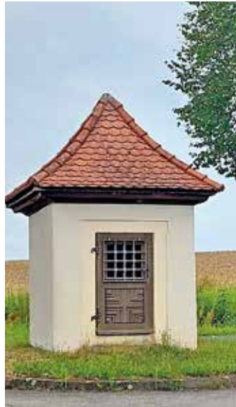
Auch mit dem Zustand der Kapelle in Failshof hatte sich der Marktgemeinderat zu befassen. Foto: Pieger
