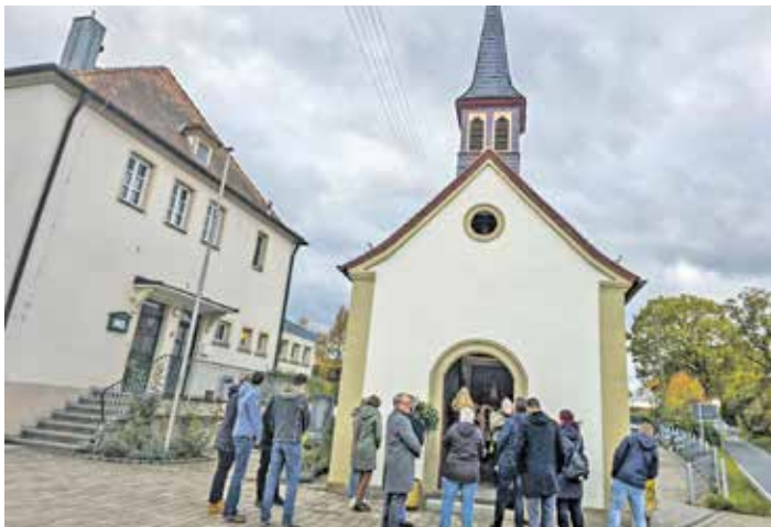
Die Steinsdorfer Kapelle erstrahlt nach der gelungenen Sanierung in neuem Glanz.
